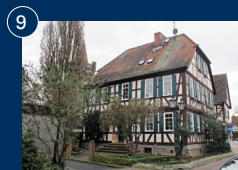
9 Ehemaliges Försterdienstgehöft - Kellereigasse 1
